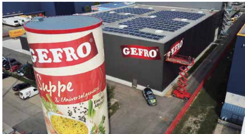
Aus dem Sprinklerturm wurde die größte GEFRO Suppendose der Welt
